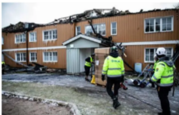
Saneringsföretag inledde sitt arbete vid brandplatsen under onsdagen. FOTO: LARS DAFGÅRD
